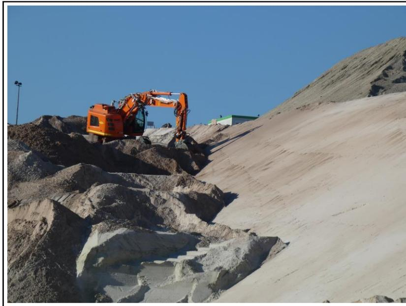
**Extraction des matériaux et travaux de terrassement latéraux des talus de la carrière pour la réalisation des casiers (septembre 2023).**
